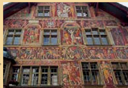
malovaná fasáda, Schaffhausen
